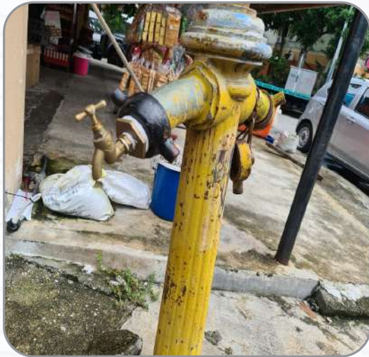
Gambar 2: Pili Bomba diubahsuai
