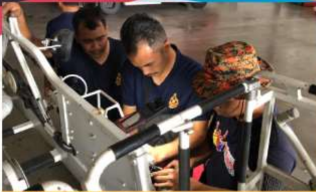
28.02.2019 - Team TTL sedang menjalankan kerja-kerja penyelenggaraan Turn Table Ladder JBPM Negeri Selangor
