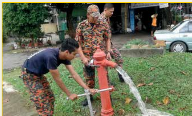
Ujian pengeluaran air pada Pili Bomba
