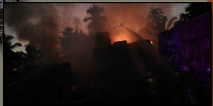
KEBAKARAN KILANG DI E- PPOR PACK, JALAN PERMATANG KELING- TANJONG BEREMBANG, NIBONG TEBAL, PULAU PINANG MELIBATKAN KILANG PENYIMPANAN KERTAS KITAR SEMULA PADA 22.03.2020.
