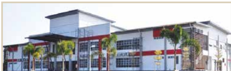
Akademi Bomba dan Penyelamat Malaysia/ Fire and Rescue Academy Tronoh, Perak
