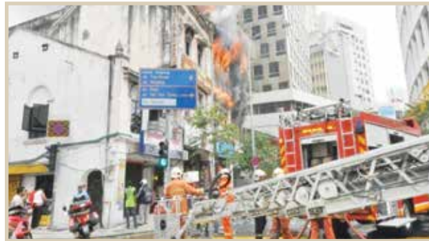
Kebakaran rumah kedai di jalan petaling (kawasan Jagaan) Fire on shoplots in petaling street
