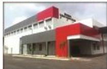
Makmal 2 (Blok Makmal Ujian Kebakaran)
